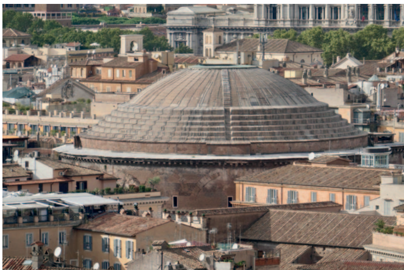
Fig. 7. Tross noen svakheter i konstruksjonen, har Pantheon stått i bortimot to tusen år. Byggene rundt Pantheon-kuppelen er antakelig ikke like bestandige. Foto: Wikipedia.
