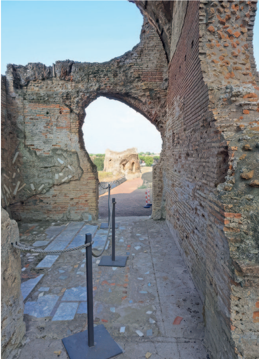
Figur 5. Dette byggverket finner vi i Villa dei Quintili, som ligger i nærheten av Roma, og som ble besøkt av NKF's ekskursjon i 2021. Muren til høyre viser en vanlig romersk byggeteknikk: Mellom to vegger av murstein er det fylt opp med mørtel og et mer eller mindre uryddig tilslag av teglstein. Foto: Ingvar Botnen.
