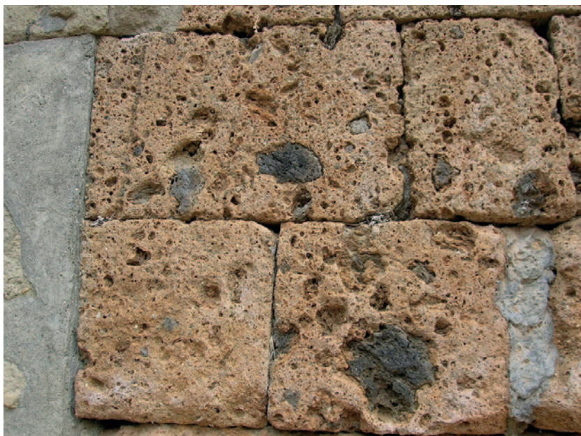
Figur 4. Vulkansk tuff fra en etruskisk grav i Lazio. Materialet er porøst og fullt av vesikler. Slikt materiale, tilhugget som her eller i knyttnevestore biter som pukk, og som kan ha pozzolaniske egenskaper, var tilgjengelig som murstein og tilslag i betong for romerske ingeniører og arkitekter. Fra wikipedia.
