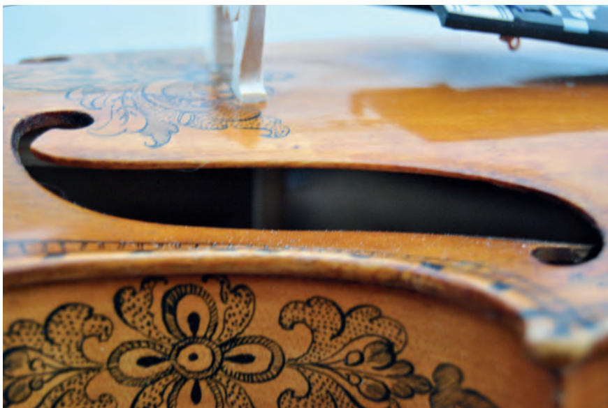
Fig. 3: Lydhøla på Olaf G. Hellands instrument vart etterkvart eit varemerke, dei er som oftast spesielt lange, og særleg elegant utforma. På biletet ser me eit typisk lydhold på ei hardingfele han laga i 1912.
