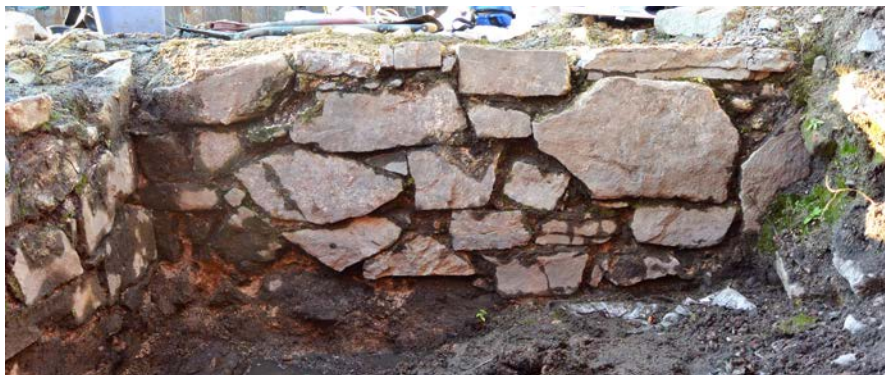
Figur 9: Gotisk murverk i søndre del av vestmuren i steinkjellerens østre rom. Foto: Morten Stige, Byantikvaren i Oslo.
