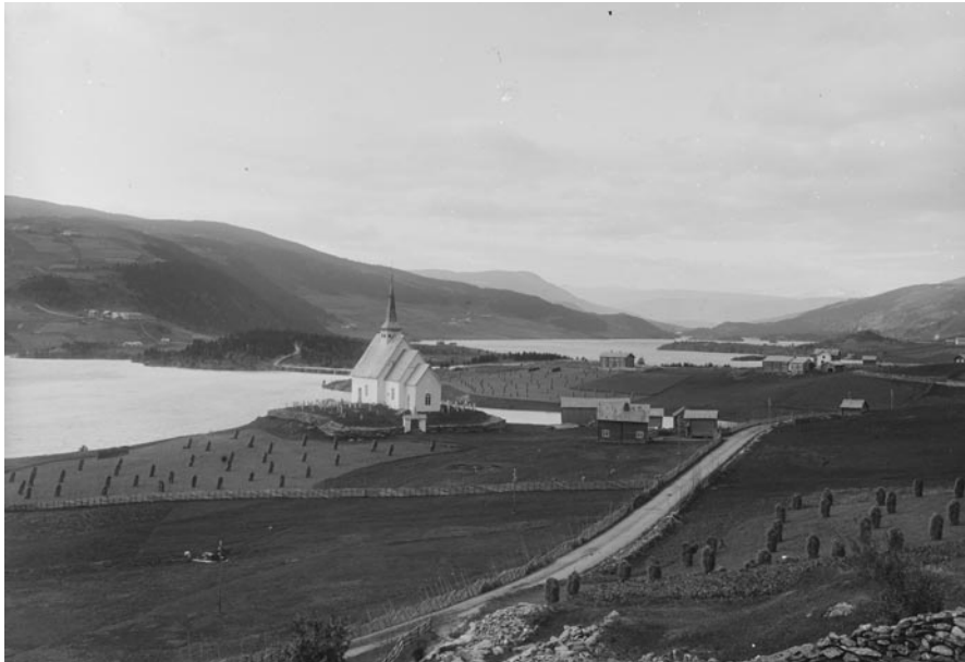
Figur 8. Ulnes kirke ved Strondafjorden i Nordre Aurdal i Valdres kommune. Det er kjent 38 kirker i Valdres i middelalderen, hvorav bare tre steinkirker, deriblant Ulnes, i tillegg til 23 stavkirker og 12 tradisjonsbelagte kirker. Kirken er trolig ombygd i gotisk stil på slutten av 1200-tallet, jf. dendrodateringer av takverket. Kirken er reist oppe på en gravhaug med diameter rundt 40 meter. Foto 1898, Marthinus Skøien. CC BY-SA 4.0.
