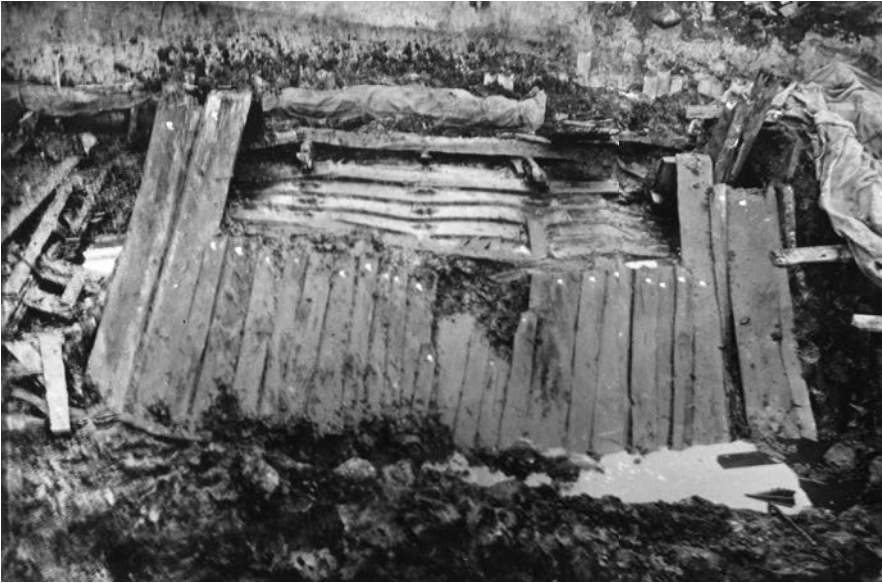
Fig. 4. Gravkammerets tak rengjort med den oppskutte bunn fra V. Utgravningen Oseberg 12.08.1904 (Væring, Kulturhistorisk museum Cf00038).
