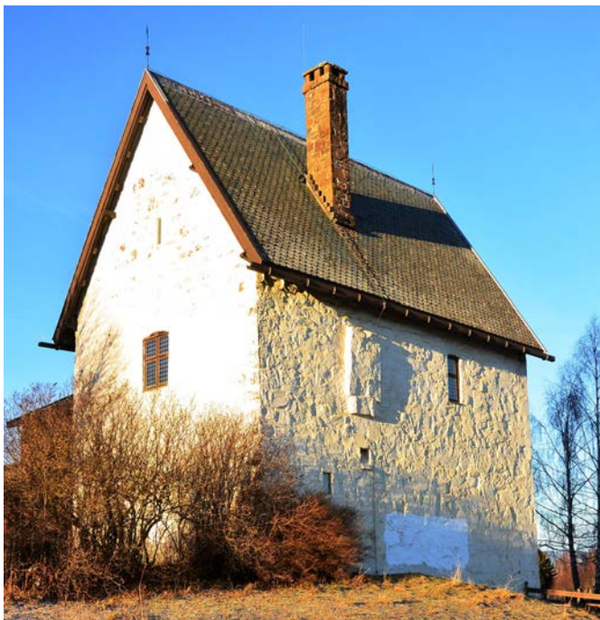
Figur 5: Steinhuset på Gran på Hadeland, landets eneste bevarte steinbygning fra middelalderen utenfor byene. Steinhuset har kjelleretasje og underetasje forbundet av et trapperom. Hele overetasjen utgjør en sal. Foto: Morten Stige, Byantikvaren i Oslo.
